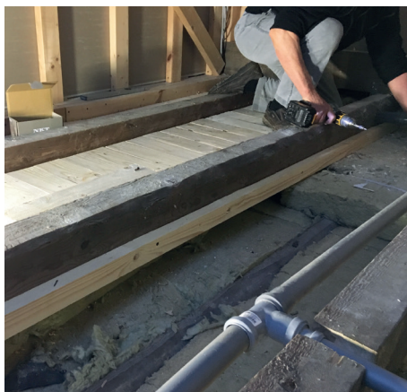
Lister monteras på befintliga bjälkar och brädor monteras på listerna.
