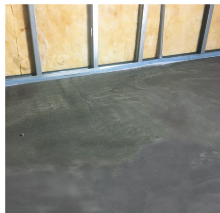
Efter 12–18 timmar, när x-plan är genomhärdad, kan våtrumsmembranet påföras och plattor monteras. Andra golvbeläggningar ska monteras enligt leverantörens anvisningar.
