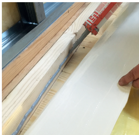
Applicera 3690 one-seal på bjälkarna, för att fästa stegljudsmattan.
